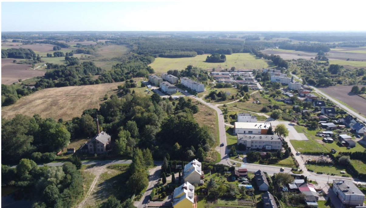
Rysunek 4. Widok na północny fragment obszaru opracowania planu oraz zabudowania m. Brzeźno, po lewej stronie widoczna jest, obecnie wyburzona, gorzelnia (zdj. własne)
